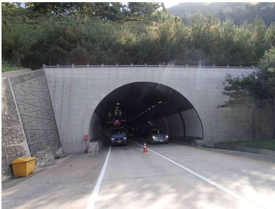
종점측 입구부 전경
