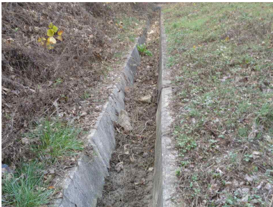
사면 배수로 전경
