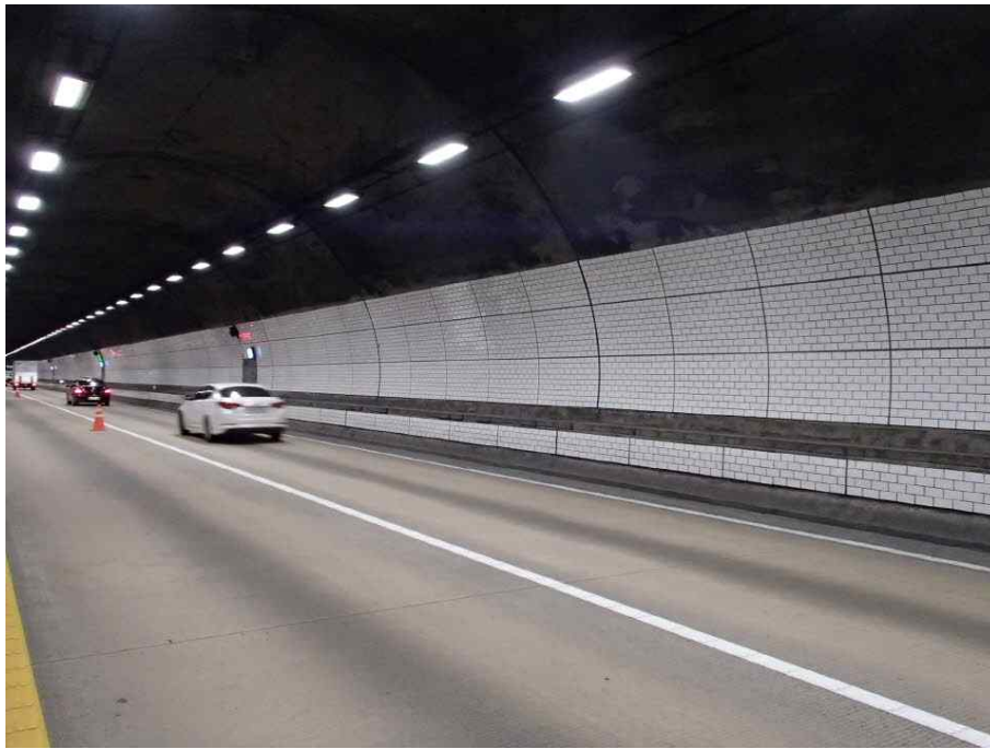
터널 내부 전경
